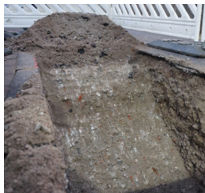
Aukikaivettu Betoroc-murskeella rakennettu katurakenne
